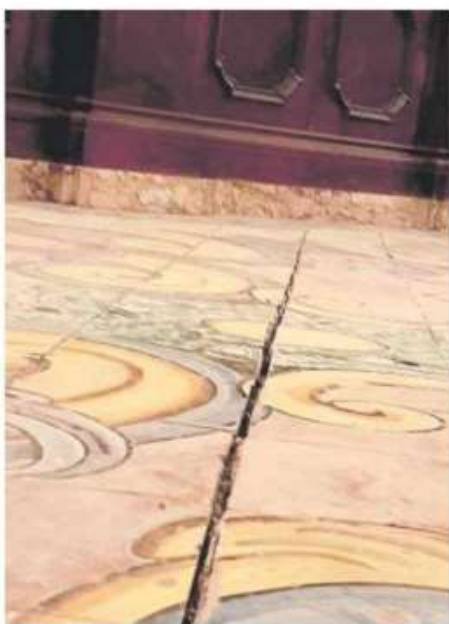
I DANNI La spaccatura sull'antico pavimento della Farmacia degli Incurabili. A destra una crepa sul soffitto della prima camera
