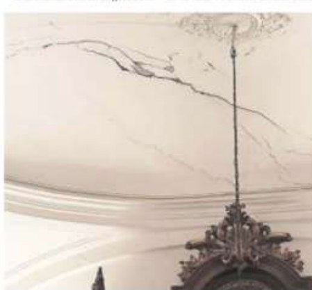
I DANNI La spaccatura sull'antico pavimento della Farmacia degli Incurabili. A destra una crepa sul soffitto della prima camera
